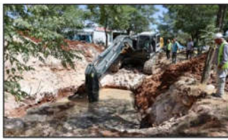
Fotoğraf 1: Su ve kanalizasyon çalışması
