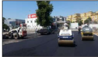
Fotoğraf 6: Asfalt çalışması
